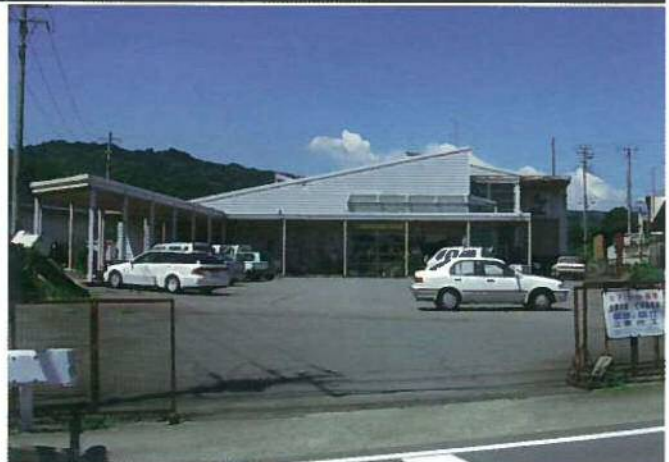
改修前の外観（ホームセンター）
