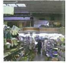
改修前のホームセンター内部
