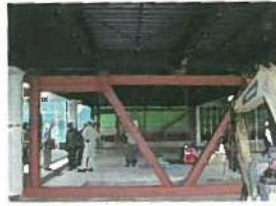
構造補強の様子
