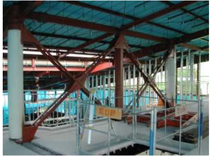
耐震補強工事状況
