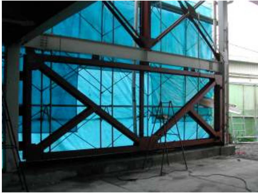
耐震補強工事状況
