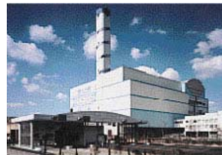
ごみ発電施設皇后崎工場(北九州市)
