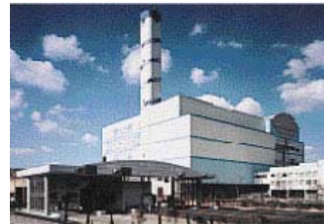
ごみ発電施設皇后崎工場(北九州市)
